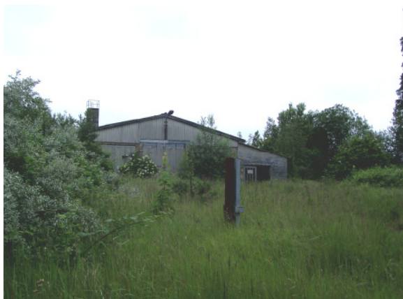
Gelände der ehemaligen Baugenossenschaft
